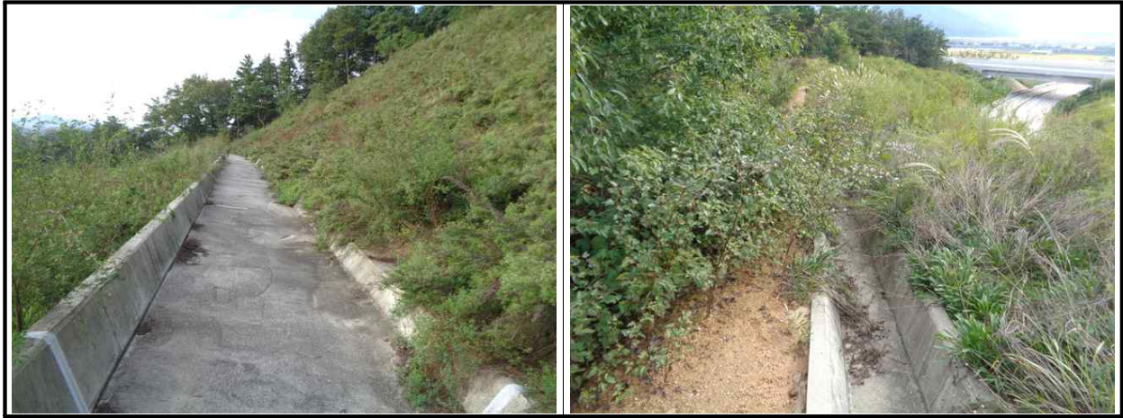
【그림 7.3.3】 배수시설 전경
