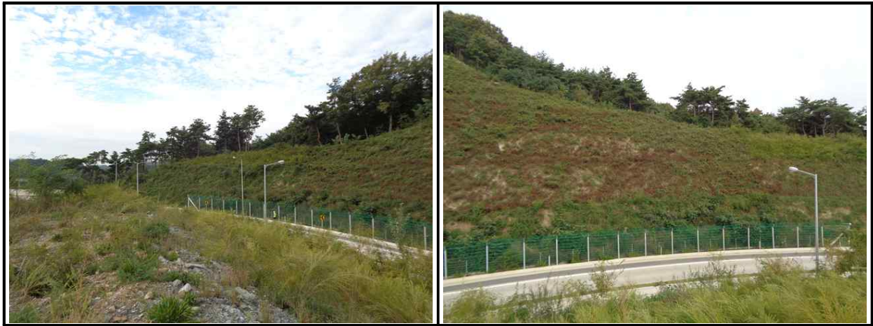
【그림 7.3.1】 상부자연사면 전경
